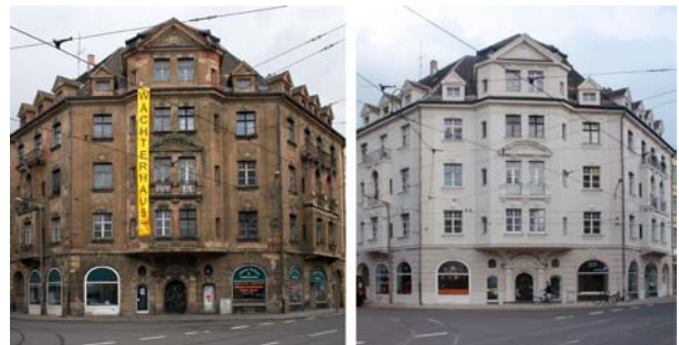
Die Demmeringstr. 21 vor und nach der Fassadensanierung
