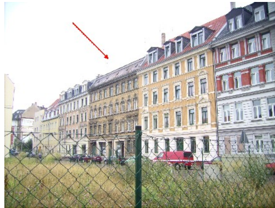
neues Wächterhaus Merseburger Straße 17
