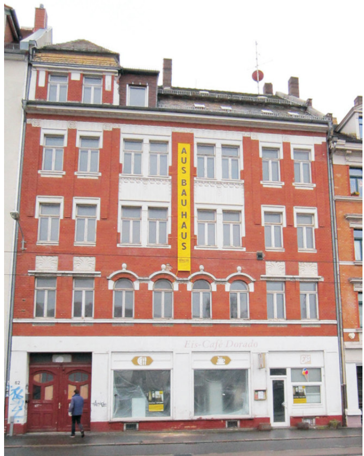
Wurzner Straße 62, Straßenansicht
