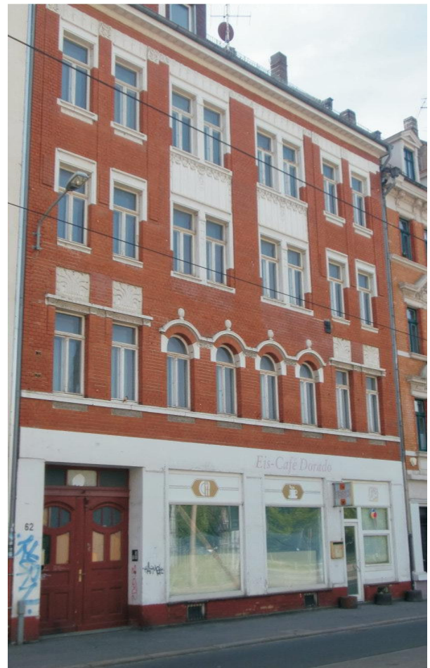
Wurzner Straße 62, Straßenansicht
