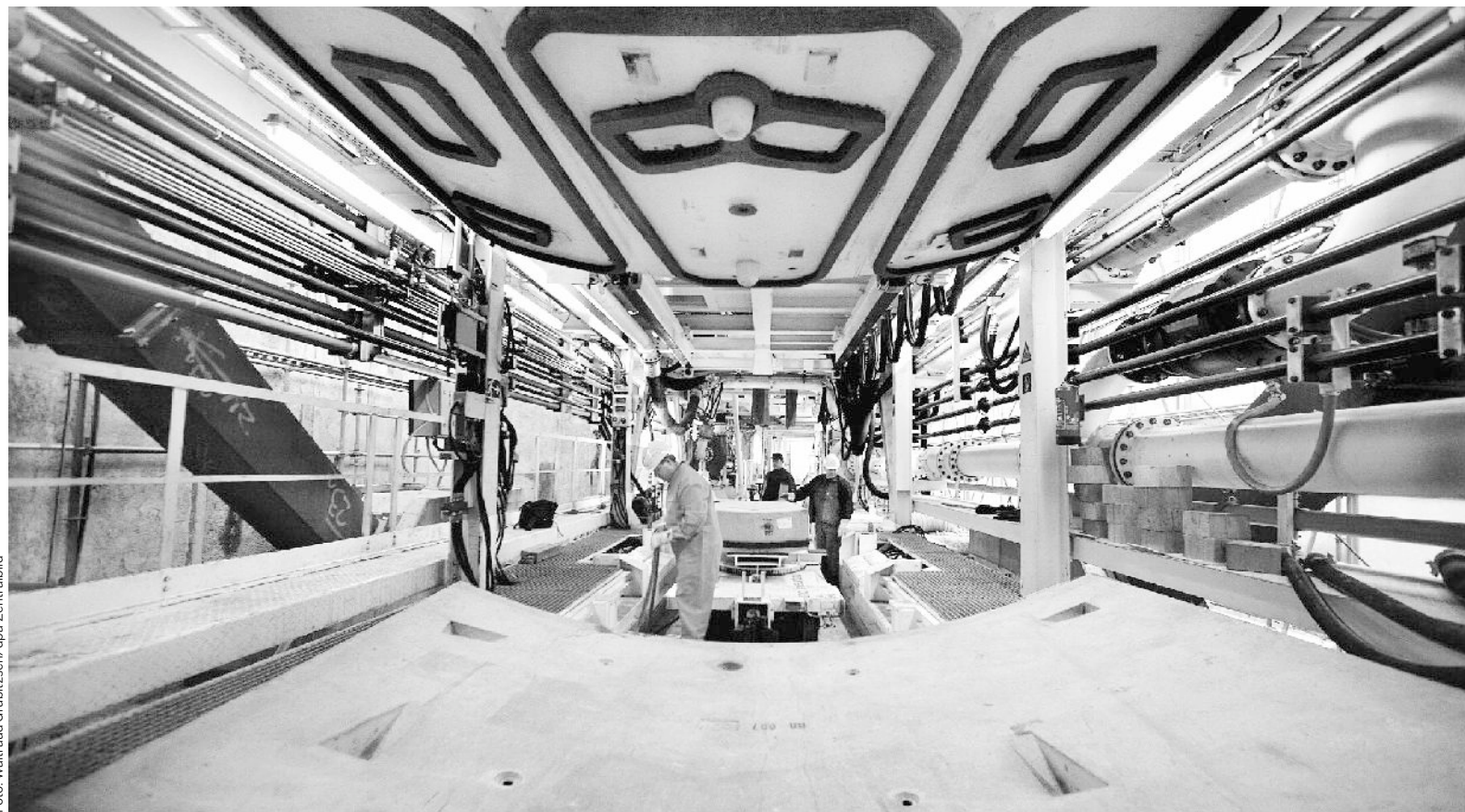
Tunnelbauer bereiten die riesige Schildvortriebsmaschine vor, die den City-Tunnel zwischen dem Hauptbahnhof und dem Bayerischen Bahnhof in Leipzig bohrt.
