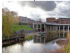
Wegen Grundstückmangels baute man
