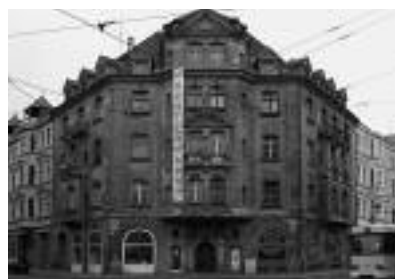
D21; gesichertes Baudenkmal Demmeringstraße 21 in Leipzig-Lindenau (Foto: HausHalten e.V.)
